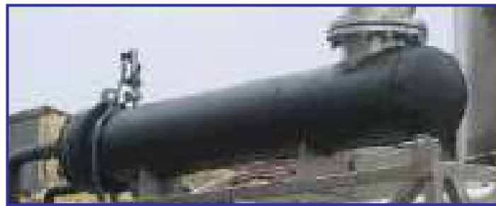
Scambiatore a fascio tubiero
